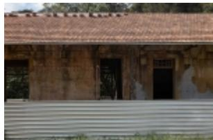
A histórica Estação de Engenheiro Corrêa, em Ouro Preto, avança significativamente em seu processo de restauração, entrando em uma nova e importante fase. Após as etapas iniciais de limpeza e cercamento da área, foi realizado o escoramento completo da estrutura, para garantir a integridade das paredes. Um importante trabalho realizado em seguida foi o reforço estrutural das fundações para dar estabilidade a todo o prédio.
