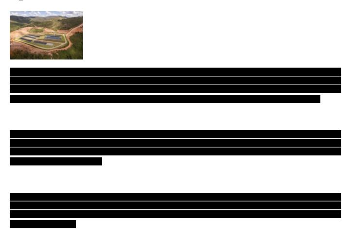
Já a ETA está instalada no ponto mais alto do novo distrito de Bento Rodrigues. Assim, a distribuição é feita por gravidade, ou seja, não precisa de bombeamento, o que reduz custos e facilita a manutenção do sistema de abastecimento. A estrutura contém dois reservatórios – de 130 mil litros e de 40 mil litros de água tratada –, que será distribuída para toda a comunidade.
